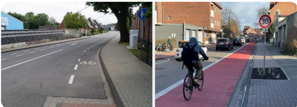
Abbildung 6: Radschutzstreife (links) und Radfahrstreifen (rechts)
